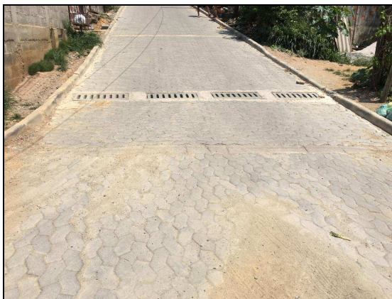
Foto 23 - Rua com calçamento e drenagem, desprovida de passeios.
