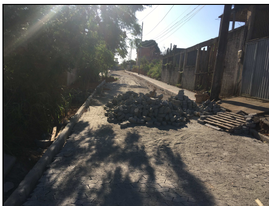
Foto 25 - Obras de calçamento no bairro Campo Belo.
