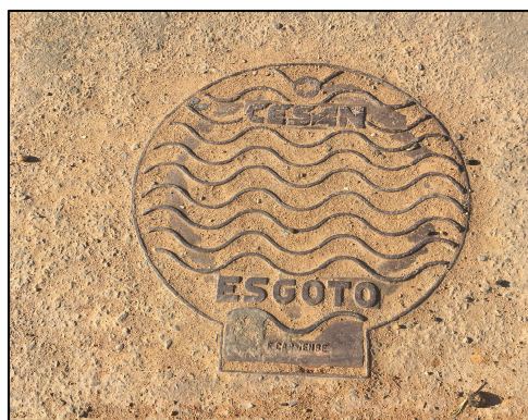
Foto 36 - Boca de visita da rede de esgoto existente em frente ao empreendimento.
