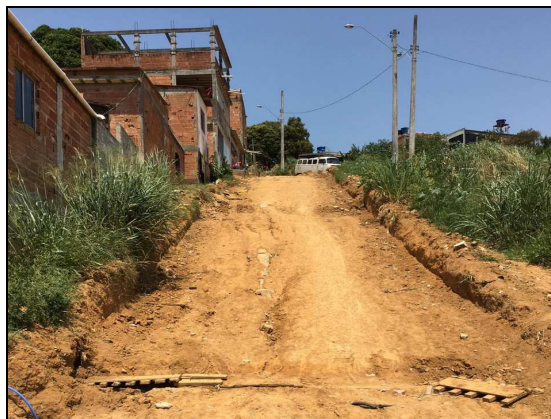
Foto 34 - Rua despavimentada, sem calçadas e drenagem.
