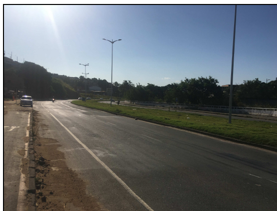
Foto 04 - Rodovia Leste Oeste, acesso ao posto, sentido Vila Velha.
