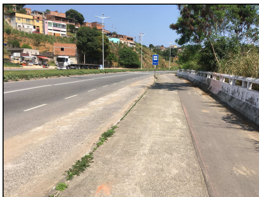
Foto 02 - Ponto de ônibus nº 01 na Rodovia Leste Oeste sentido Campo Grande.
