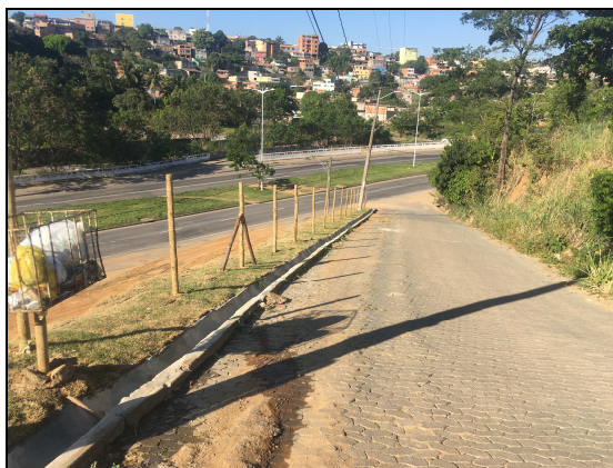
Foto 20- Rua Ubuzeiro desprovida de calçadas.
