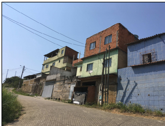
Foto 12- Residências com 3 pavimentos na Rua Pinheiros, bairro Campo Belo.
