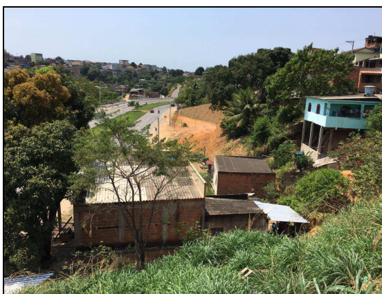
Foto 16 - Residências sobre encostas. Fonte: Arquivo pessoal, 2020.
