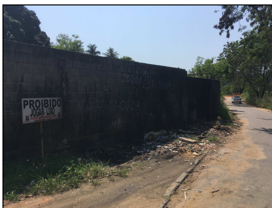
Foto 22 - Calçada obstruída por muro e com lixo urbano queimado.
