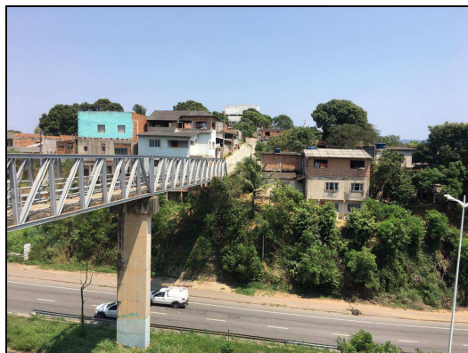
Foto 31 - Passarela sobre a Rodovia Leste Oeste.
