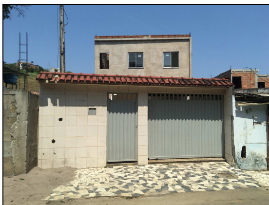
Foto 13 - Residência com 2 pavimentos na Rua pântanos, bairro São Benedito.
