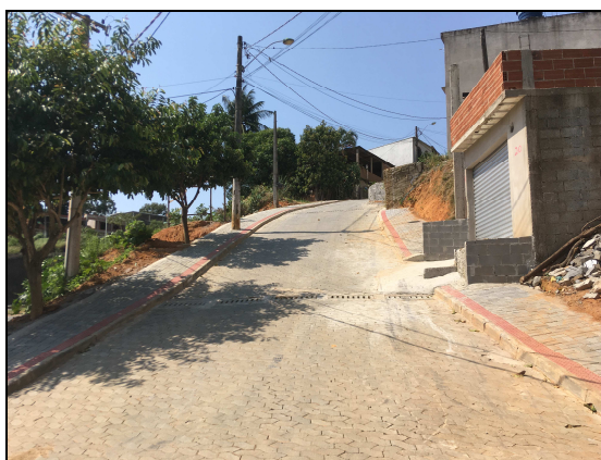
Foto 24 - Rua Seringueira com calçadas cidadãs, obstruídas por moradores.
