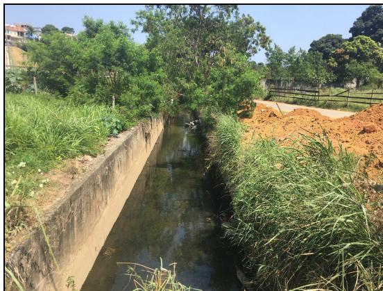
Foto 10 - Arborização no canal de drenagem. Fonte: Arquivo pessoal, 2020.
