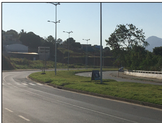
Foto 40 - Boca coletora de drenagem pluvial no canteiro central e iluminação pública.
