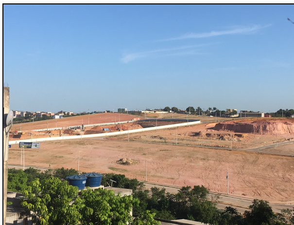
Foto 01 - Obras de implantação do Hospital Estadual de Cariacica e loteamento VTO.
