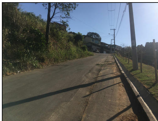
Foto 38 - Canaleta de drenagem no entorno do terreno do posto e rede de energia.
