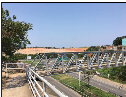
Foto 30 - Passarela sobre a Rodovia Leste Oeste em Campo Belo.
