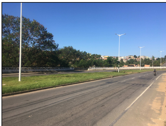
Foto 05 - Rodovia Leste Oeste, saída do posto, sentido Vila Velha.
